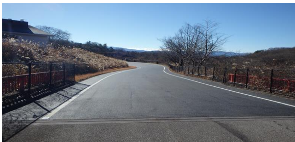
(1工区②) 完成 1号橋手前付近
