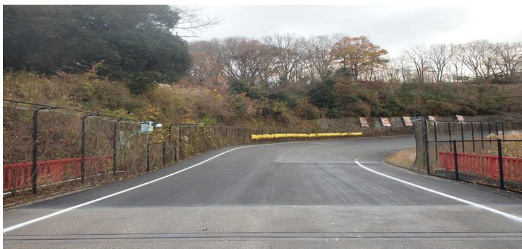
2工区) 完 成 2号橋手前付近
