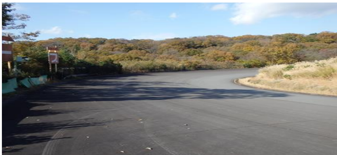
(1工区①) 着工前 第1下り付近
