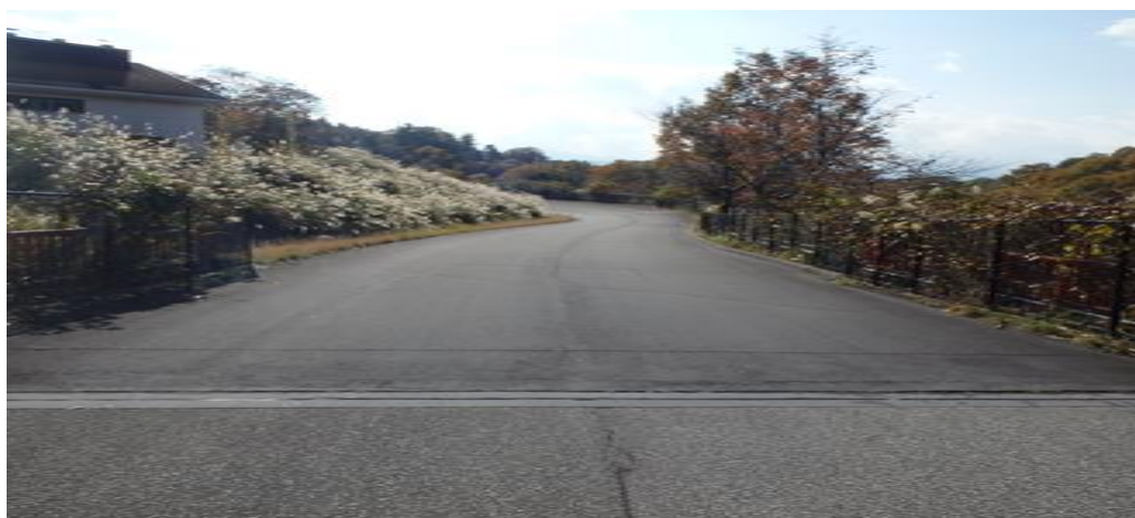
(1工区②) 着工前 1号橋手前付近
