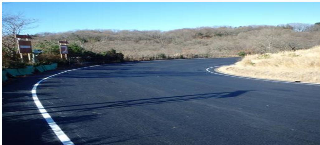
(1工区①) 完成 第一下り付近
