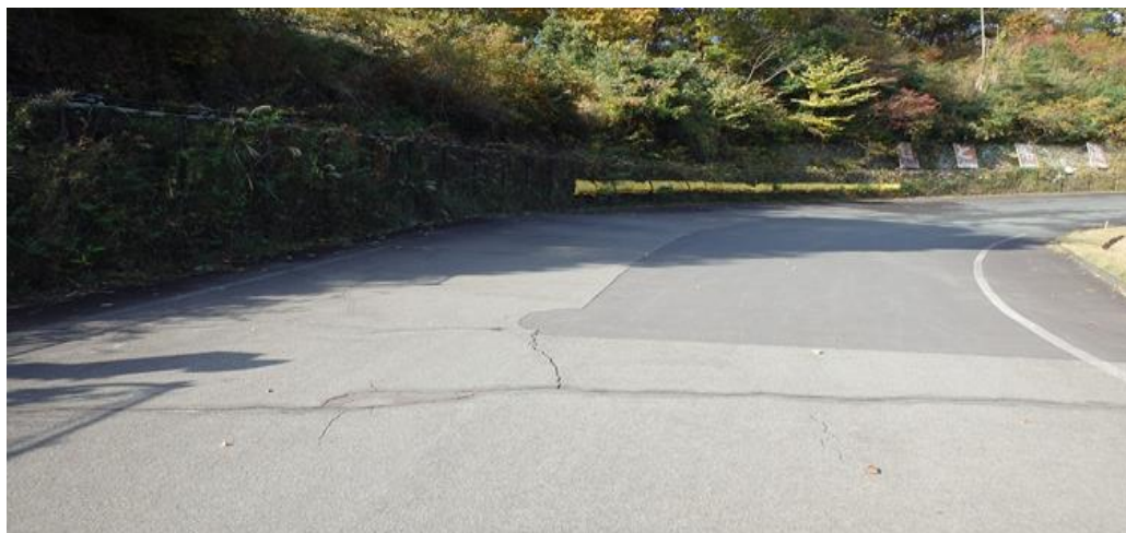
(2工区) 着工前 2号橋手前付近
