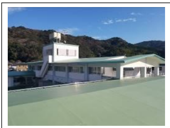
北棟屋上、南棟二階
