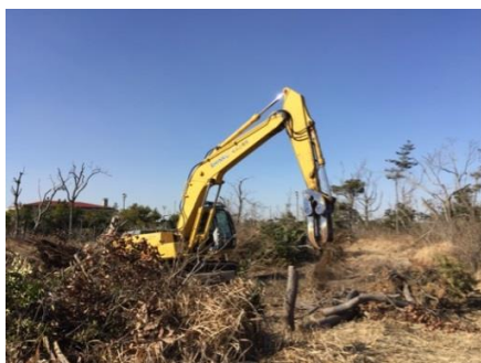
伐採した木々を重機で破碎し、チップ化します
