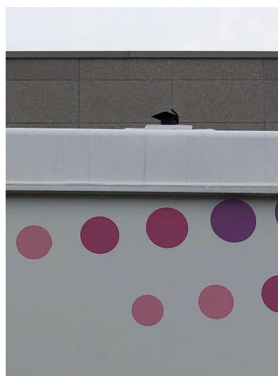
天井の排気ガスの出口
